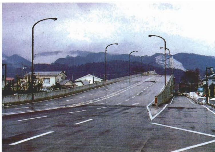
横手環状線 (平成6年度完成)
