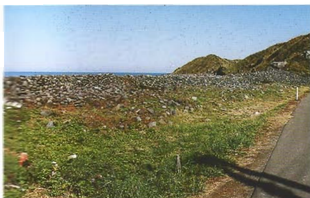
飛の波除石垣
