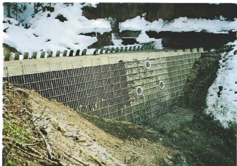
中詰に現地材を利用した砂防ダム（ヒカクラ沢川・田沢湖町）
