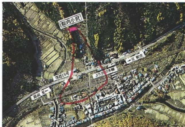
県内の交通網重点地域（院内小沢・雄勝町）
