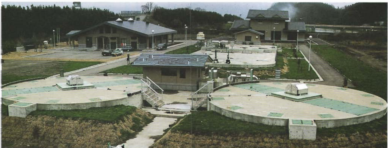
米代川流域下水道 鹿角処理センター
