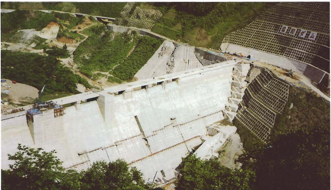
平成9年度完成予定の協和ダム
