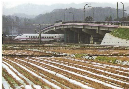
秋田新幹線の上を通過する真崎跨線橋～平成8年11月供用 （主）大曲田沢湖線（田沢湖町真崎）
