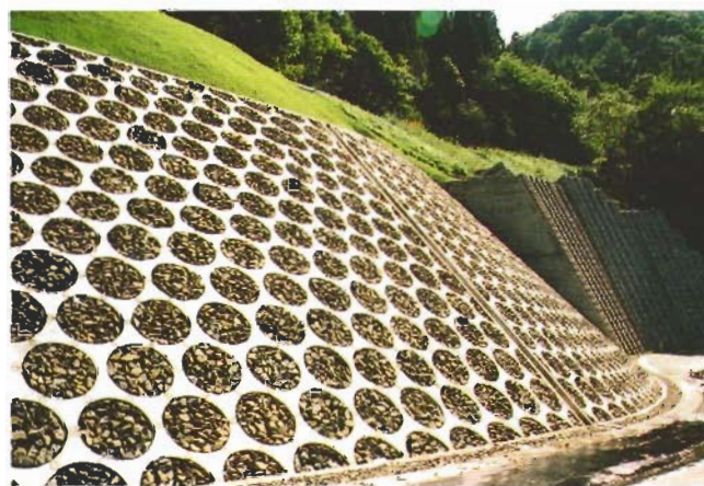
災害防除（県道田山花輪線 鹿角市）
