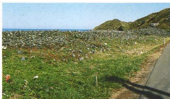
飛の波除石垣
