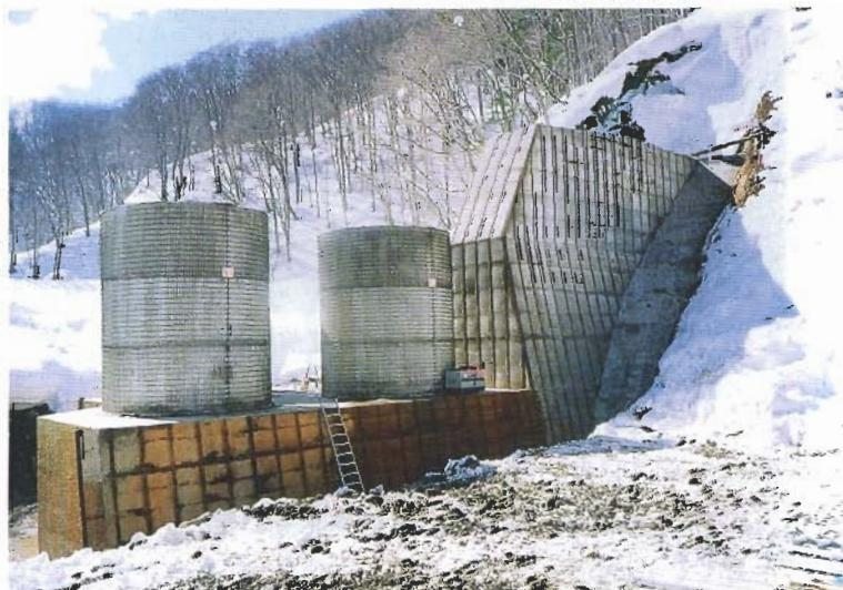
鋼製捨型枠を使用し施工中の砂防ダム（赤川・鹿角市）
