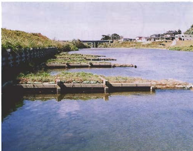
水生生物の避難場所・魚の産卵場所の確保を図った水制工 《岩見川・河辺町》
