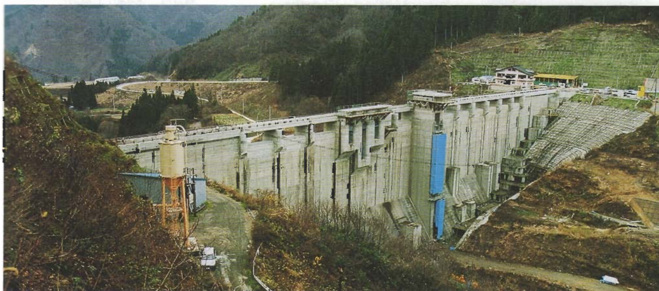
平成10年度完成予定の大松川ダム
