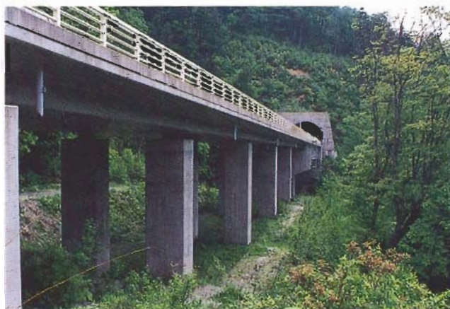
高架橋を採用して動物に配慮したエコロードの例
