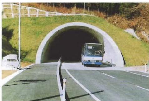
国道341号 田沢湖町 鎧畑 (鹿ノ作トンネル)
