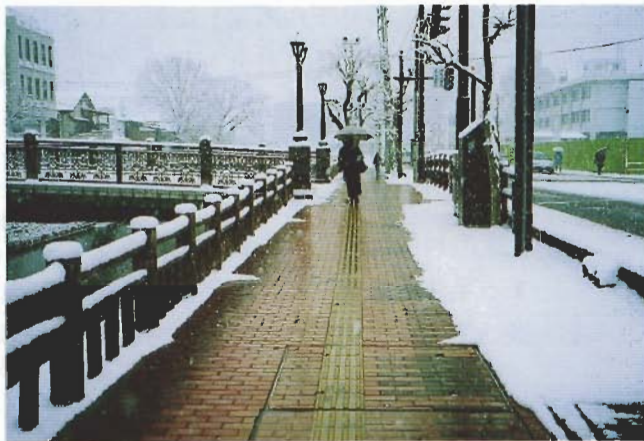
歩道無散水施設（秋田市）
