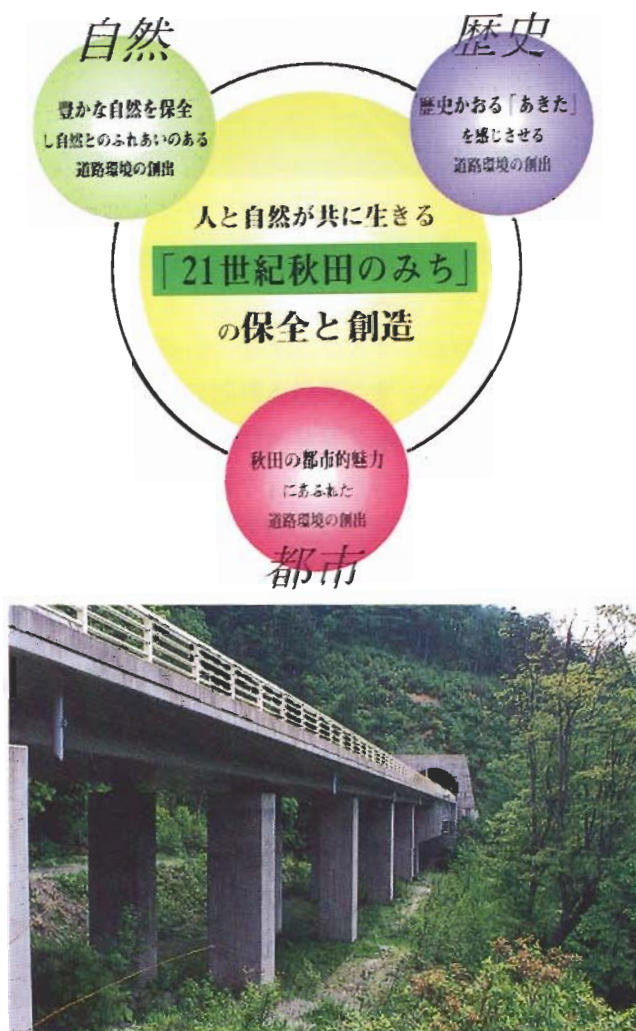
高架橋を採用して動物に配慮したエコロードの例
