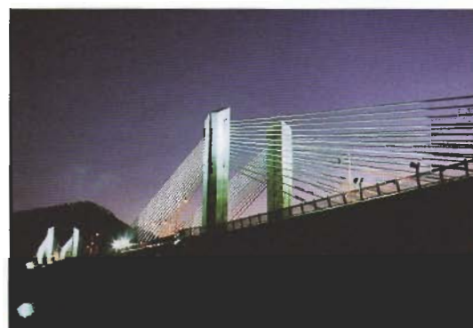
ライトアップされた翔鷹大橋 (大館能代空港アクセス道路)
