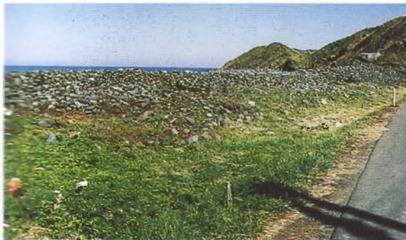
飛の波除石垣
