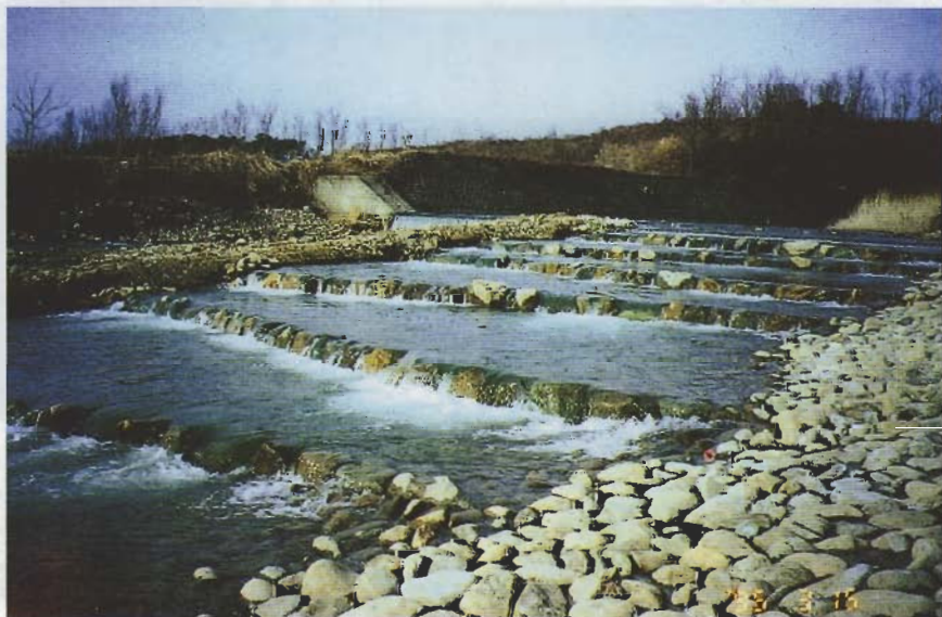
氷沢川の全断面階段式魚道(峰浜村)
