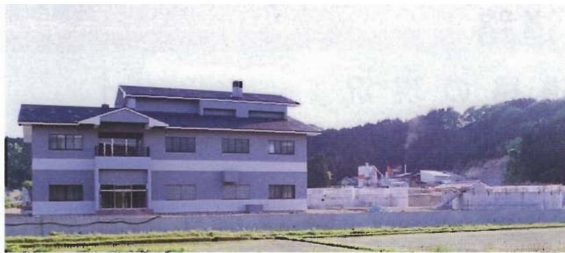
平成12年4月の供用を目指し建設中の 矢島町・矢島浄化センター
