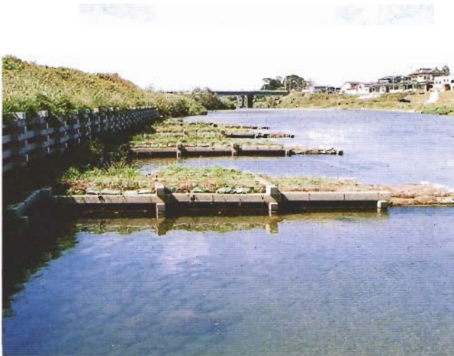
水生生物の避難場所・魚の産卵場所の確保を図った水制工 (岩見川・河辺町)
