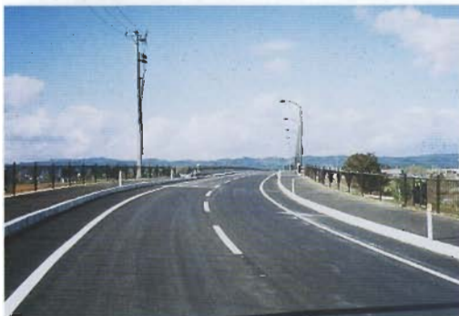
(一) 大館鷹巣線 (鷹巣町栄橋)
