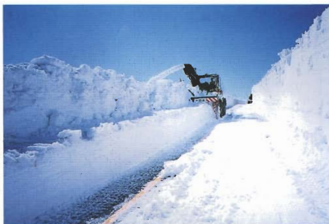
春山除雪（鹿角市）
