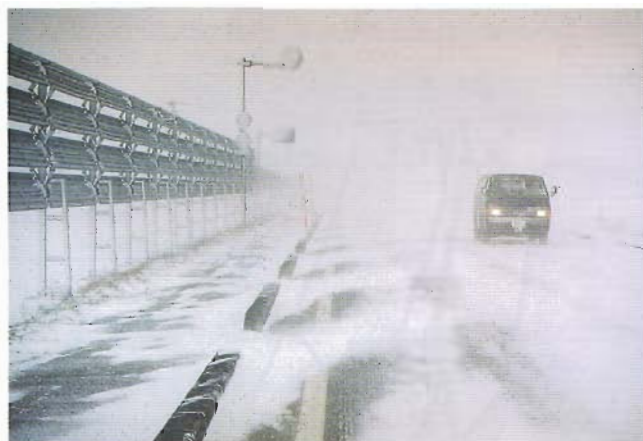
防雪柵（吹払式）（国道107号）
