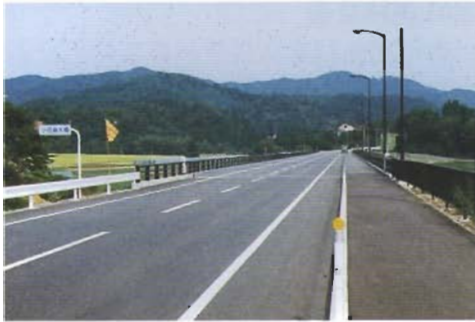
国道285号上小阿仁村南沢 (小田瀬大橋)
