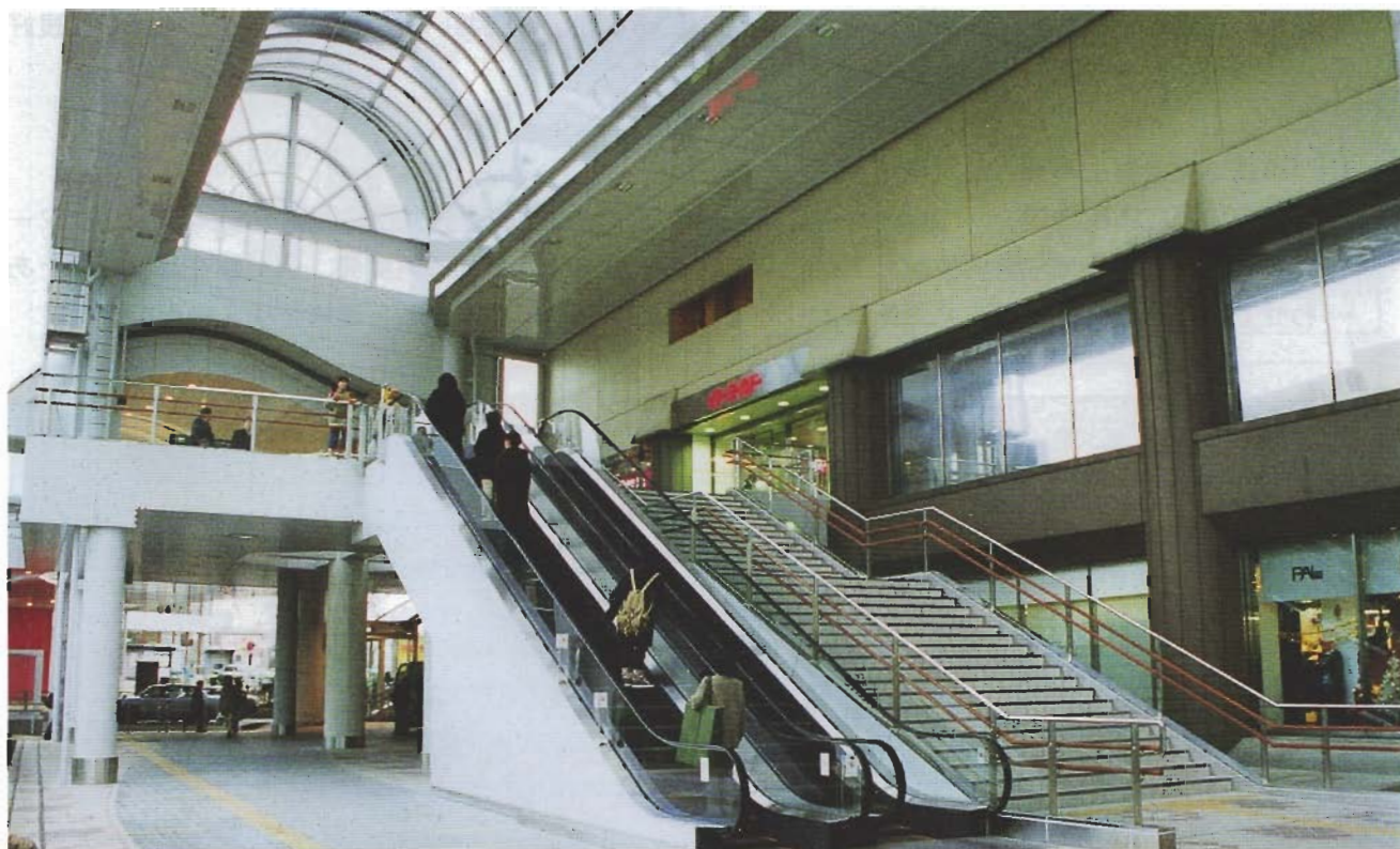
秋田駅前地区（大屋根工事）
