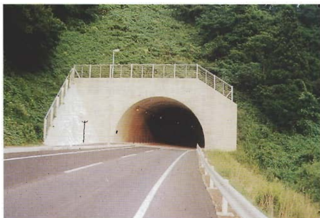
国道107号東由利町館合（板戸トンネル）
