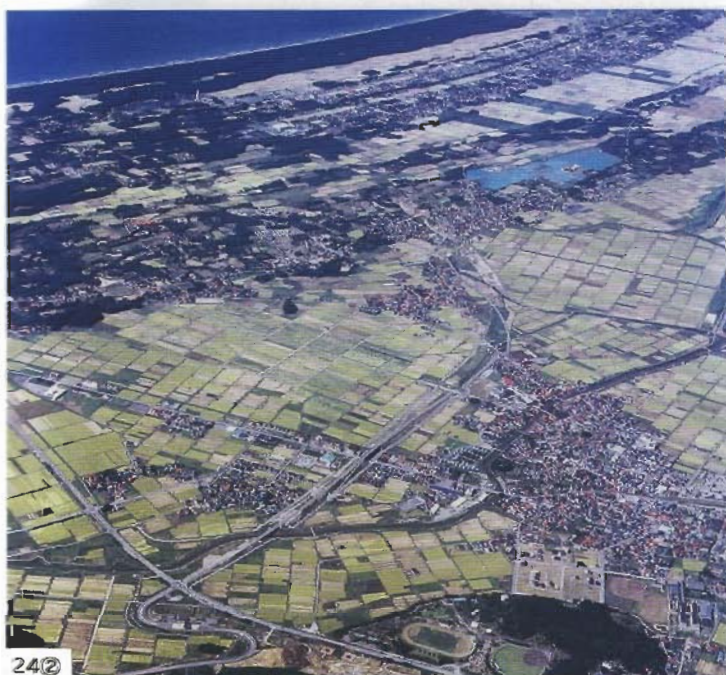
建設が進む、男鹿昭和飯田川線（手前が昭和男鹿半島！Cと国道7号）
