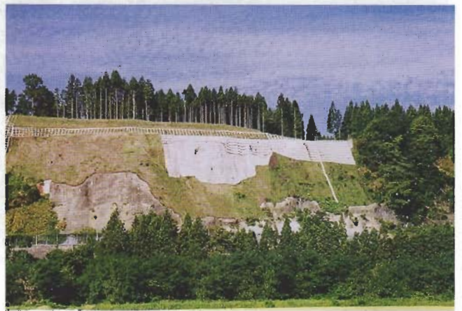
災害防除（国道108号 矢島町）
