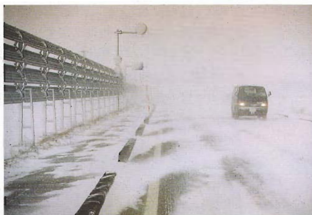
防雪柵（吹払式）（国道107号）
