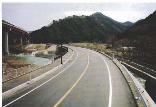
国道103号鹿角市湯瀬（湯瀬バイパス）
