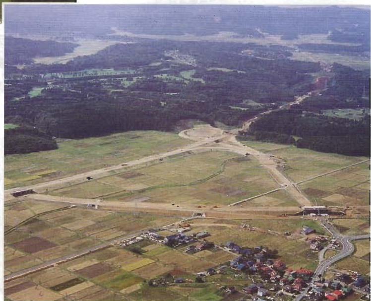
[建設が進む、日治道・河辺IC付近と交差する秋田空港アクセス道路]
