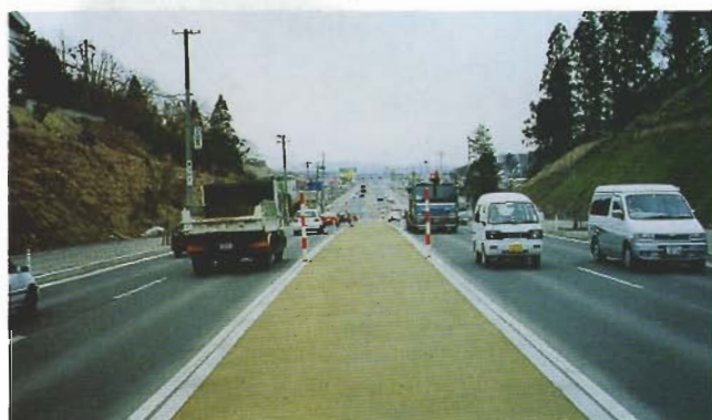
秋田昭和線秋田市桜地内4車線拡幅工事
