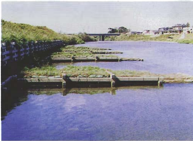
水生生物の避難場所・魚の産卵場所の確保を図った水制工 (岩見川・河辺町)
