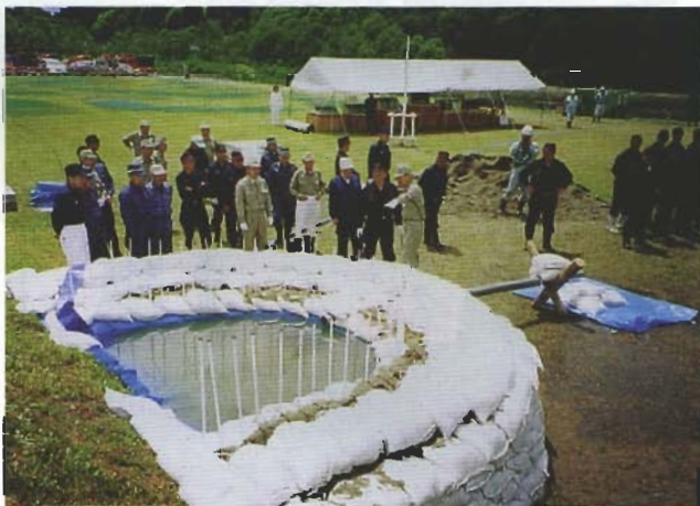
水防訓練（鹿角建設事務所管内）
