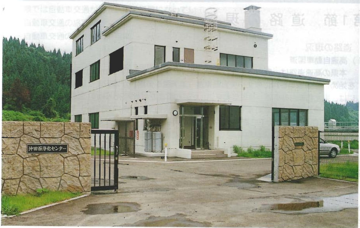
上小阿仁村 沖田面浄化センター (平成13年8月供用)
