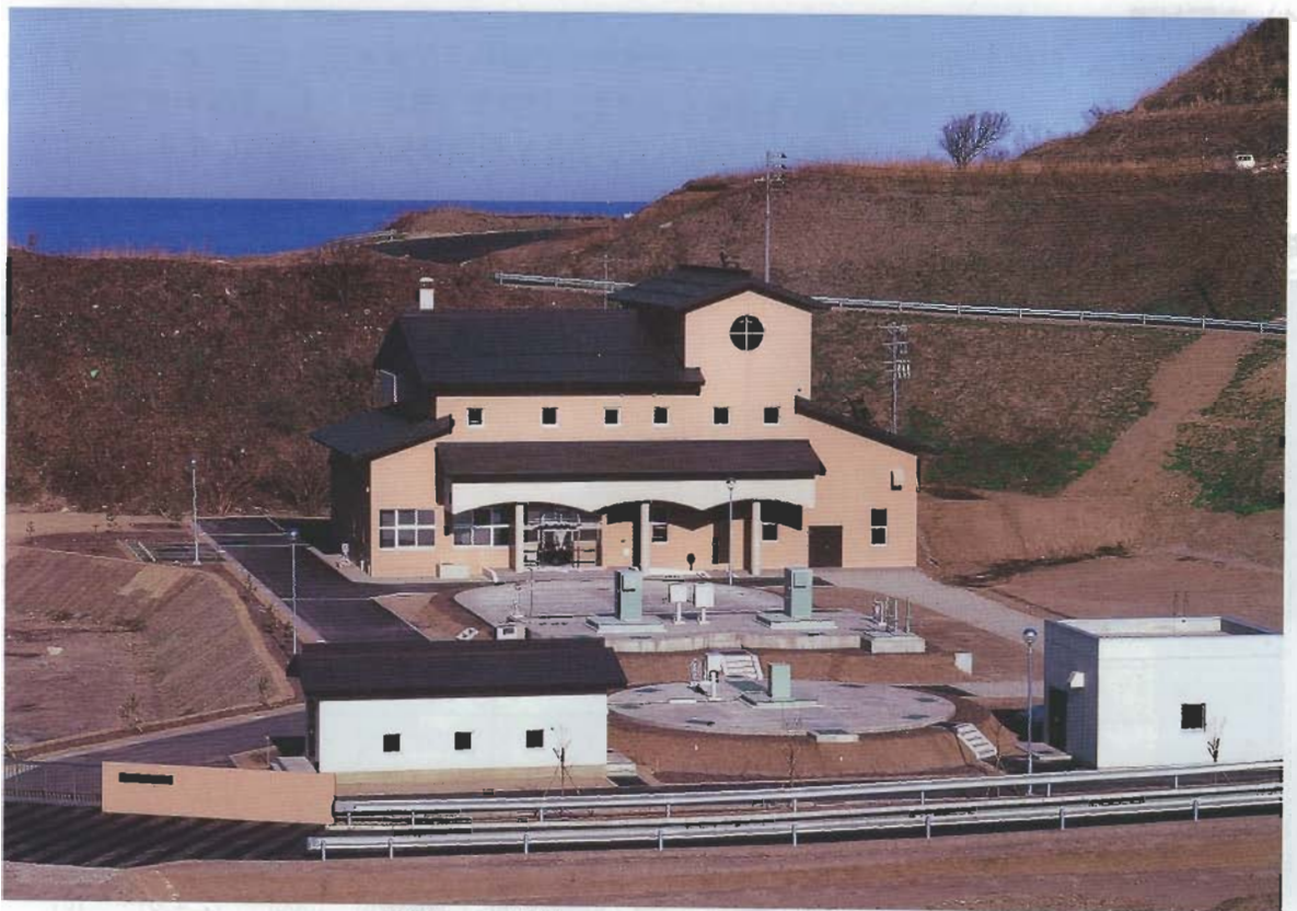
八森町 八森浄化センター (平成14年2月供用)
