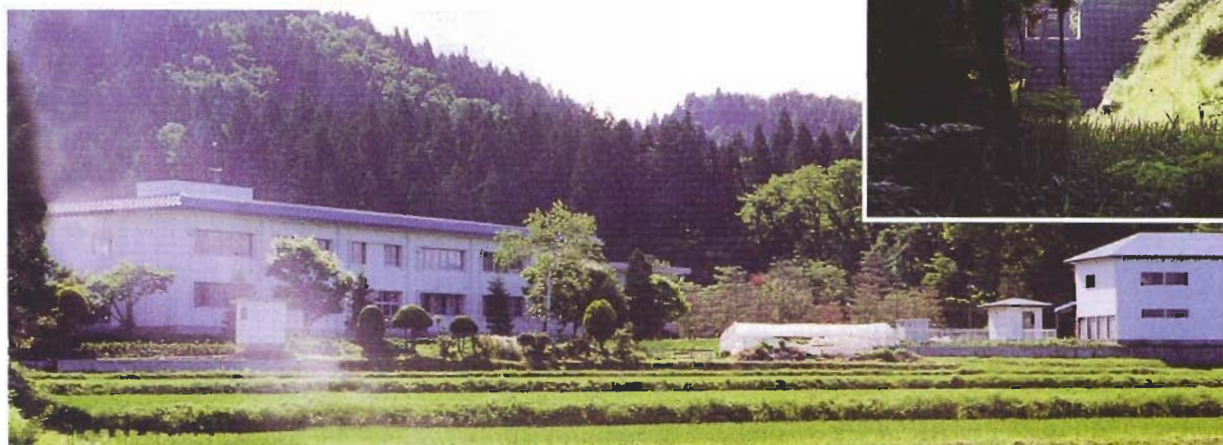
《災害弱者施設（病院）を保全する砂防堰堤 たつみ沢・大館市》
