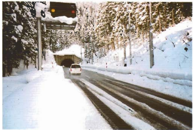
ロードヒーティング（国道285号 比内町）
