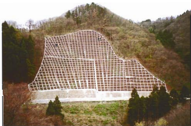
災害防除（男鹿半島線 男鹿市）
