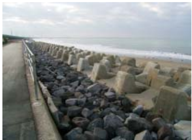
工事完成(H19)
