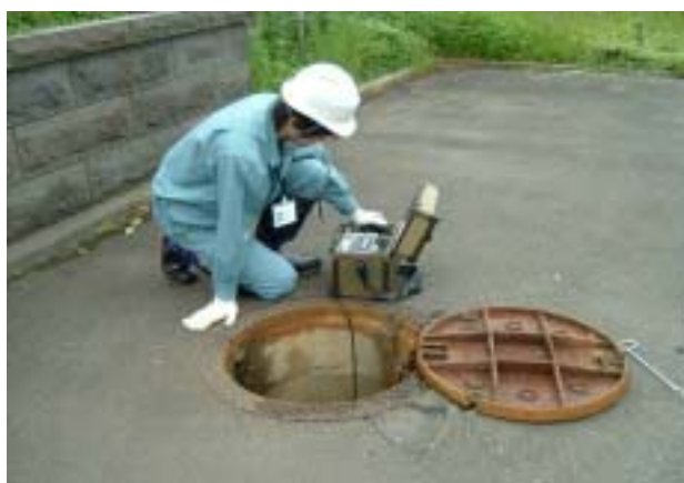
マンホールの点検
