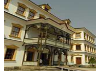
㊷ 小坂鉱山事務所
