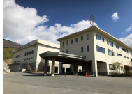
⑬⑥ 田沢湖 スポーツセンター
