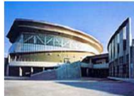
⑬④ 県立総合プール
