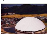
⑤⑩ 大館樹海ドーム
