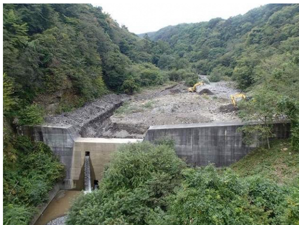
写真 4.4.1 除石工の事例（御嶽山）
