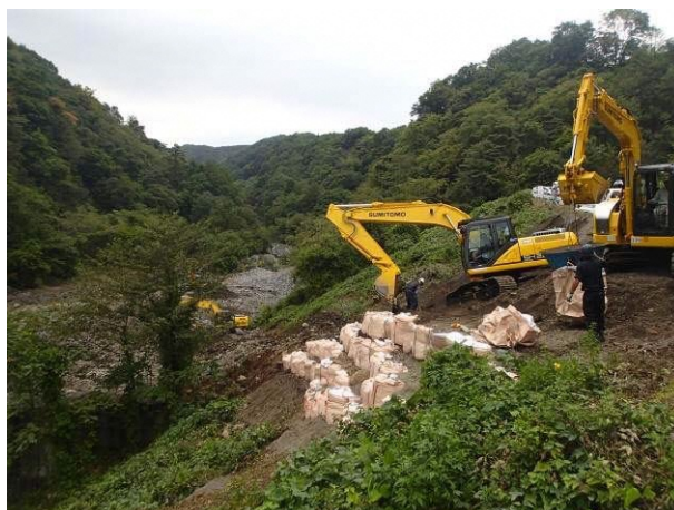
写真 4.4.2 仮設道路設置の事例（御嶽山）
