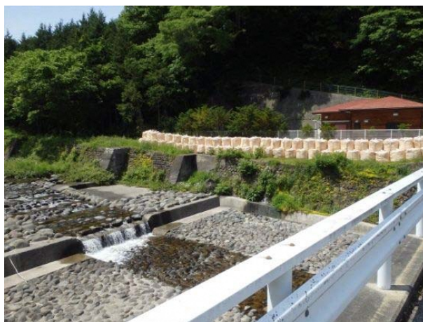
写真 4.4.4 導流堤工の設置事例（御嶽山）
