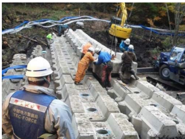
写真 4.4.3 ブロック堰堤工の事例（御嶽山）
