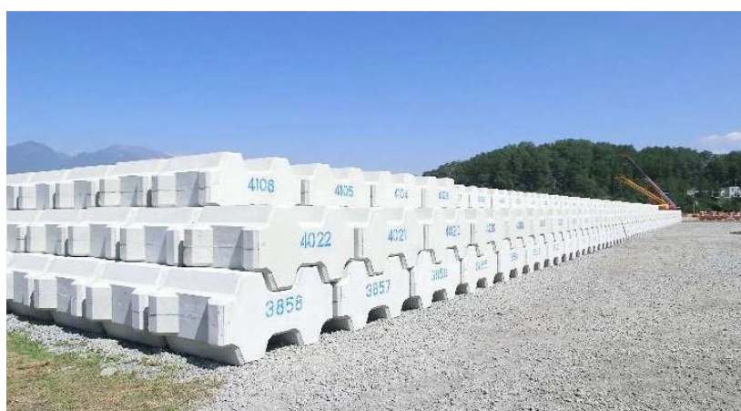
図 3-6 コンクリートブロックの備蓄例（浅間山）
