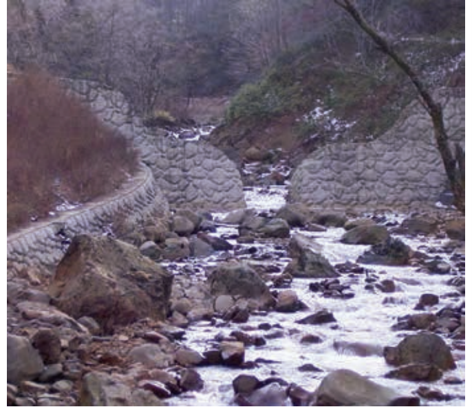
外面の化粧と上下流の連続性確保により、十和田八幡平国立公園内の景観と環境に配慮した砂防えん堤。 (仙北市・先達川)
