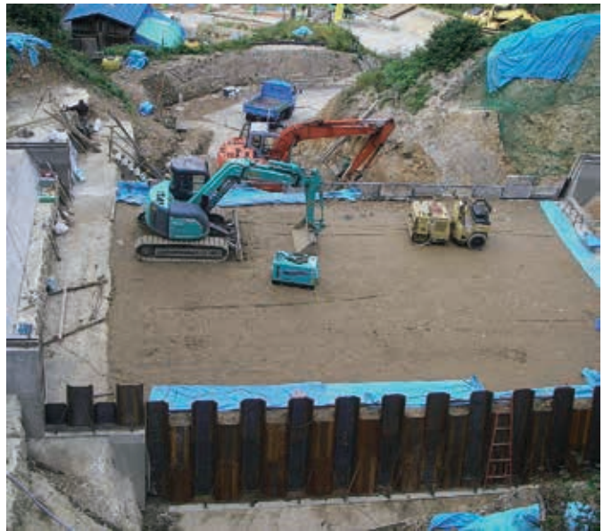
コンクリートを出来る限り使わず、現地発生土を内部に詰めた砂防えん堤。(横手市・沼山沢川)
