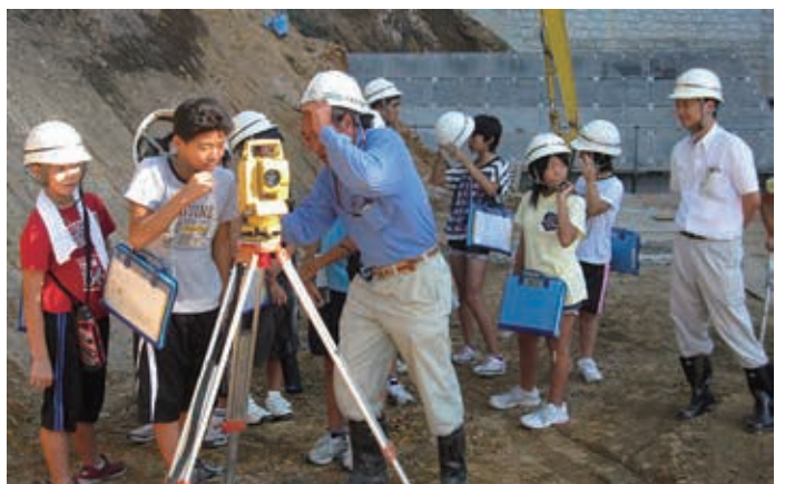
小学生を対象にした工事現場での学習会
