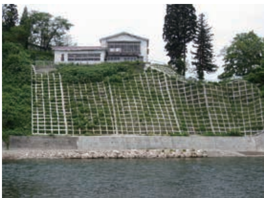
北秋田市阿仁前田八幡田地区の急傾斜地崩壊対策事業
