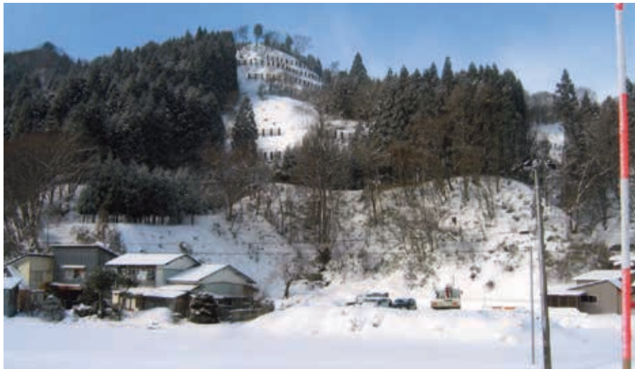
藤里町坊中の雪崩対策事業
