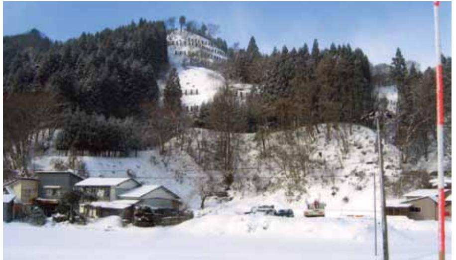
藤里町坊中の雪崩対策事業
