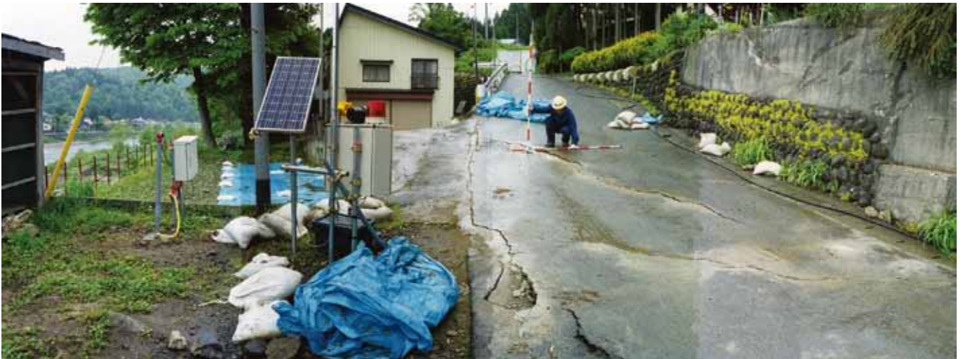
北秋田市森吉下前田の被災状況
