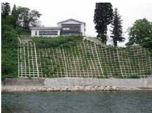
北秋田市阿仁前田八幡田地区の急傾斜地崩壊対策事業
