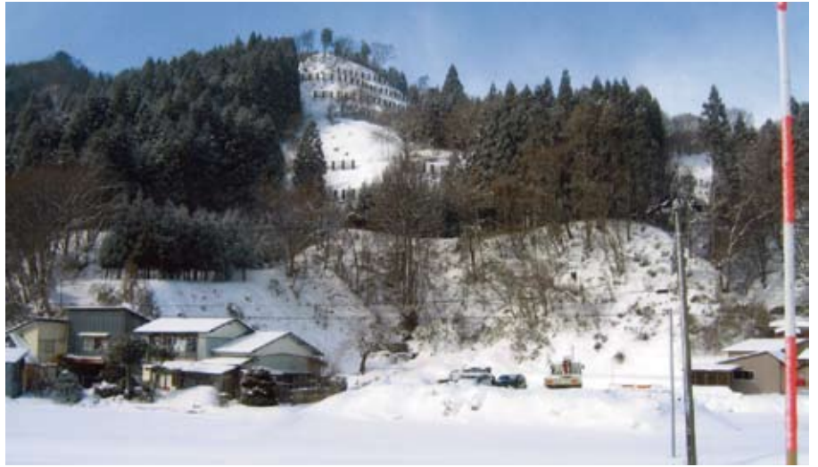
藤里町坊中の雪崩対策事業
