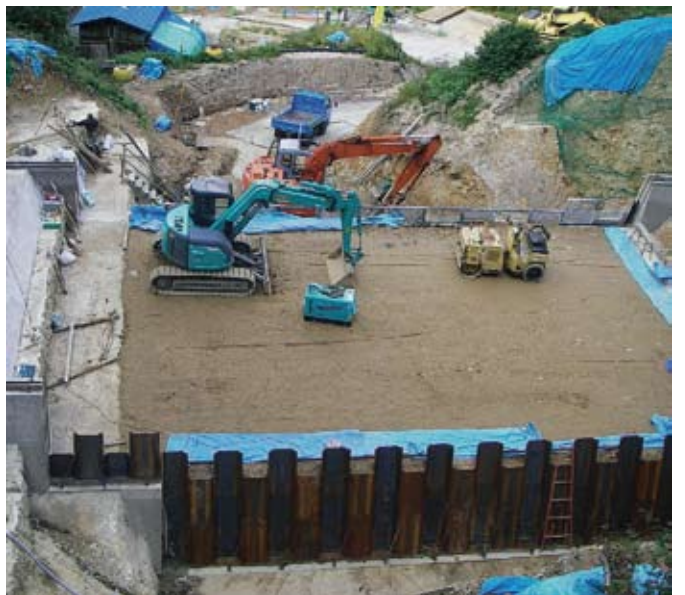
コンクリートを出来る限り使わず、現地発生土を内部に詰めた砂防えん堤。(横手市・沼山沢川)
