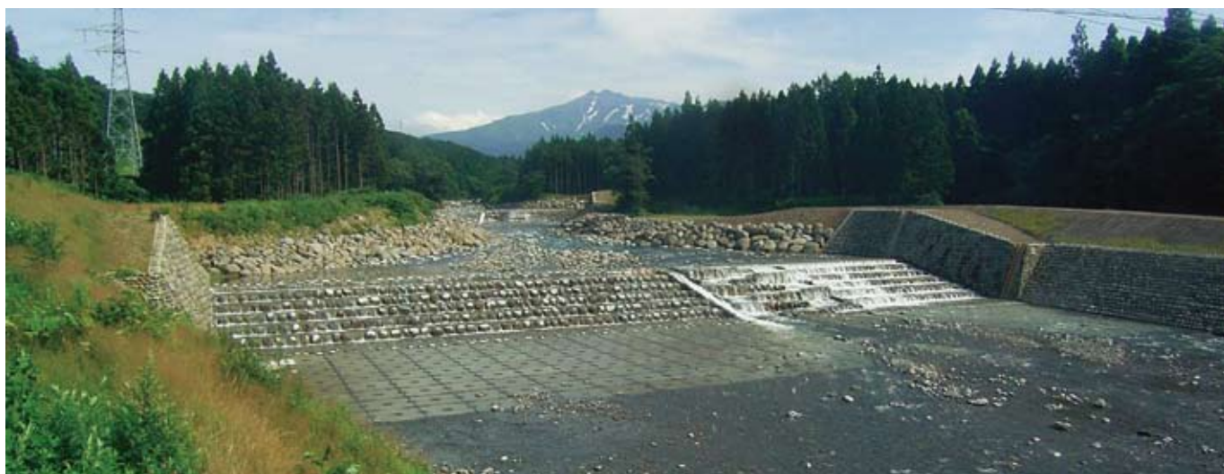
にかほ市 白雪川床固工(現地発生材の利用・魚道の設置)
