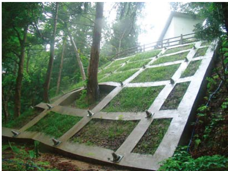
湯沢市不動滝1号の急傾斜地崩壊対策事業
