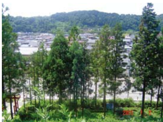
秋田市新藤田の急傾斜地崩壊対策事業
