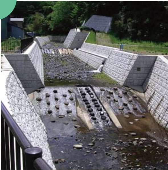
自然石を活用し魚道など整備して、生態系と環境に配慮した砂防えん堤。 (にかほ市・寒沢川)
