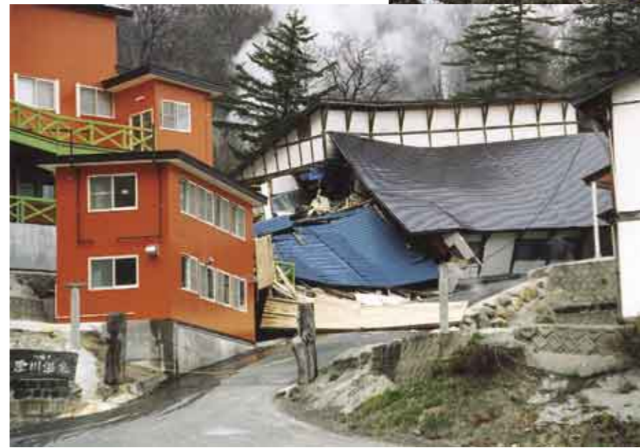
鹿角市澄川温泉／地すべりによって倒壊した温泉施設。
