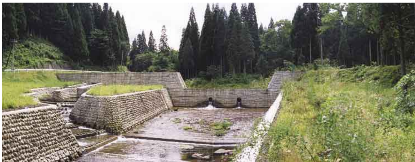
雄勝郡雄勝町桑崎地内／御返事川床固工（魚道設置）
