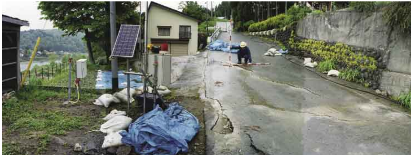
森吉町下前田の被災状況
