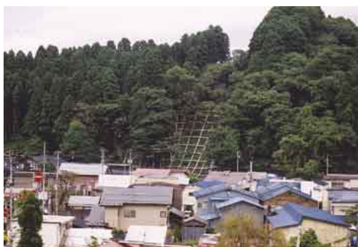
角館町田町下丁の急傾斜地崩壊対策事業
