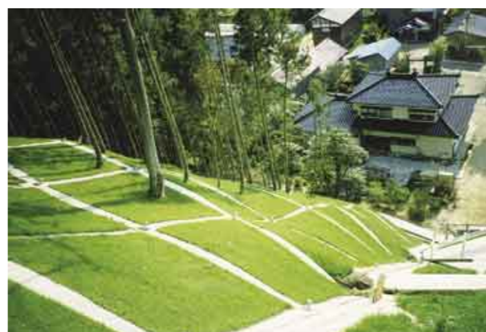
由利町蒲田の急傾斜地崩壊対策事業
