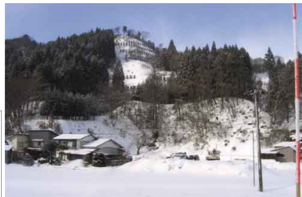
藤里町坊中の雪崩対策事業
