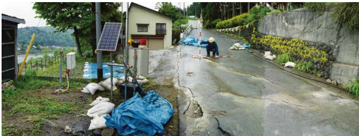
北秋田市森吉下前田の被災状況
