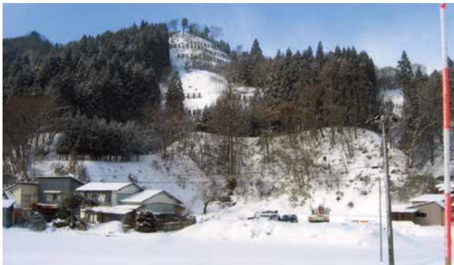
藤里町坊中の雪崩対策事業
