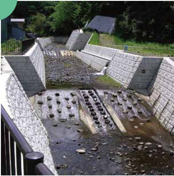
自然石を活用し魚道など整備して、生態系と環境に配慮した砂防えん堤。 (にかほ市・寒沢川)
