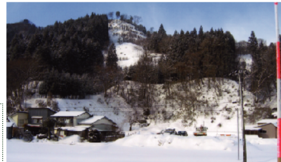
藤里町坊中の雪崩対策事業
