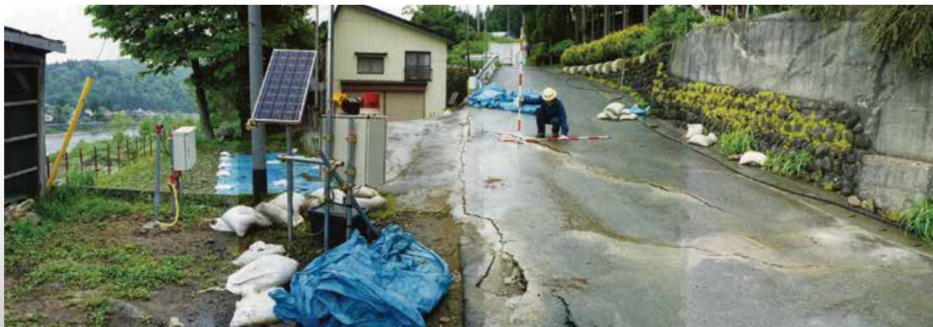
北秋田市森吉下前田の被災状況
