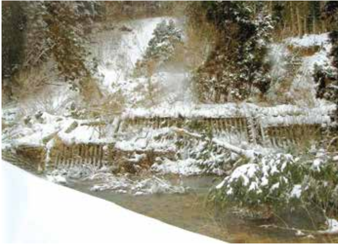
上小阿仁村五反沢地区地すべりの被災状況 1
