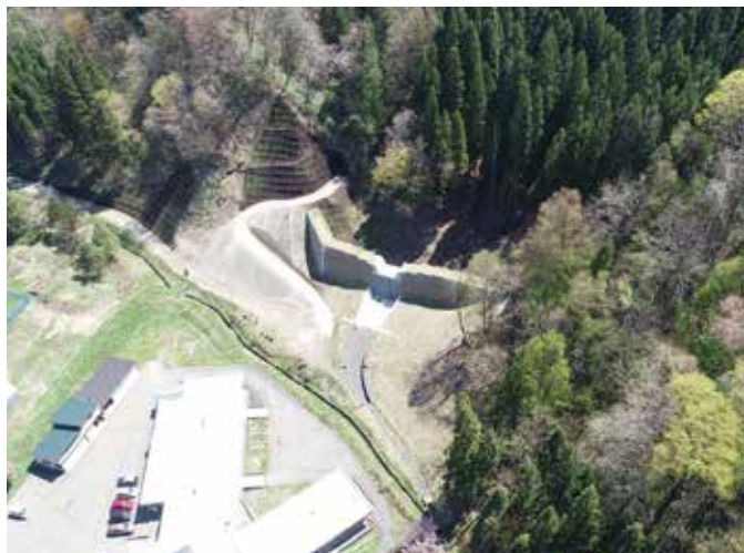
小坂町八九郎東沢砂防えん堤
