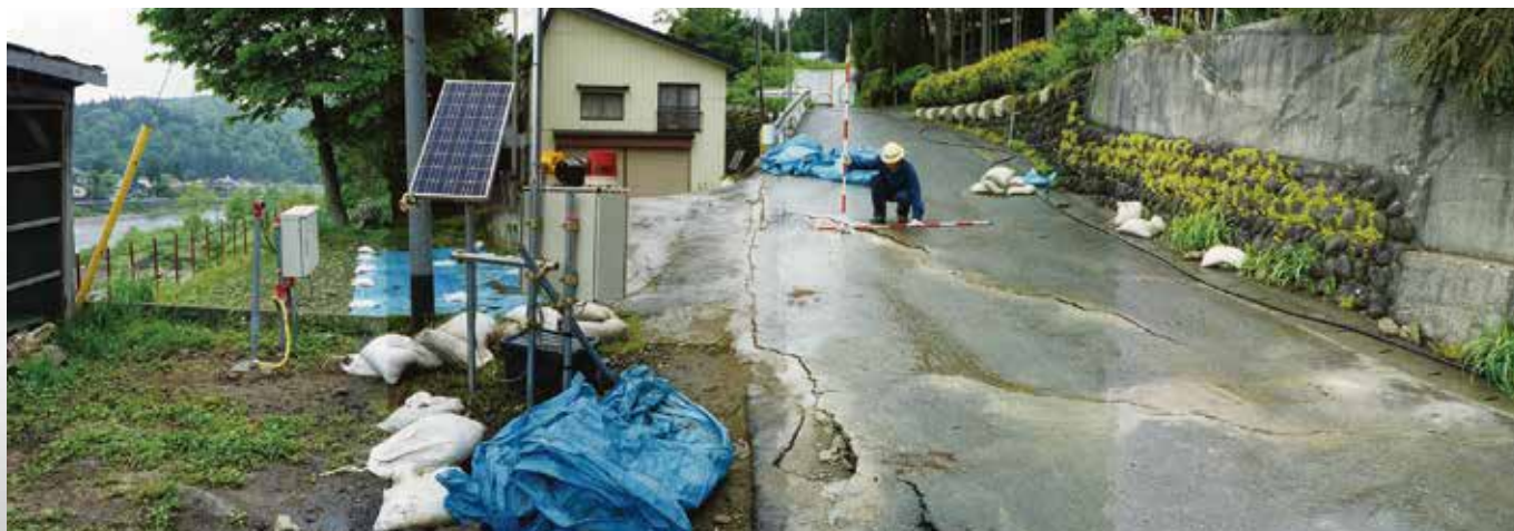
北秋田市森吉下前田の被災状況
