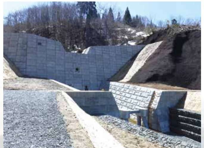
仙北市比内沢砂防えん堤
