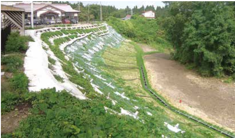
男鹿市芦沢地区の地すべり対策事業（全景）
