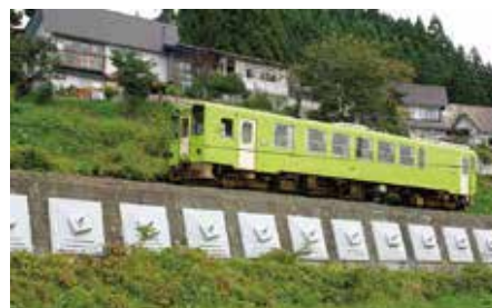
北秋田市小又下川原の対策後の状況
