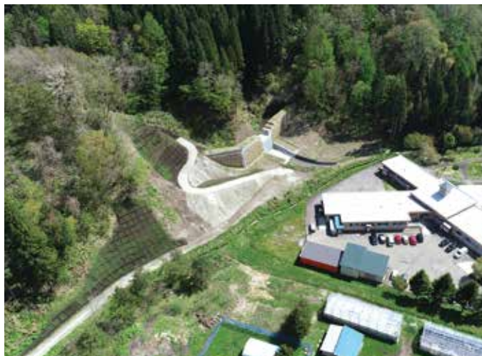
小坂町八九郎東沢砂防えん堤
