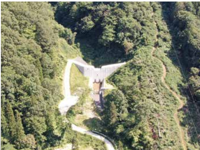
仙北市比内沢砂防えん堤
