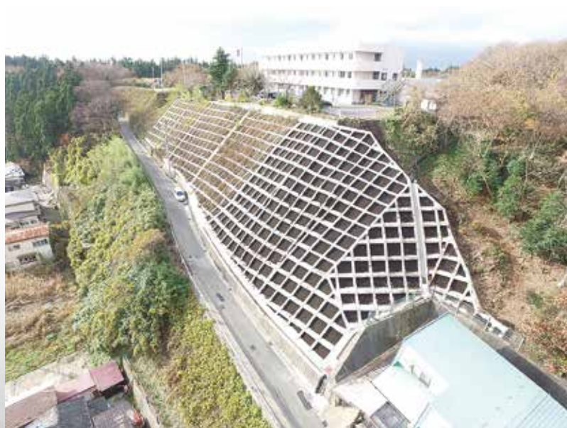
男鹿市・女川地区の急傾斜地崩壊対策事業
