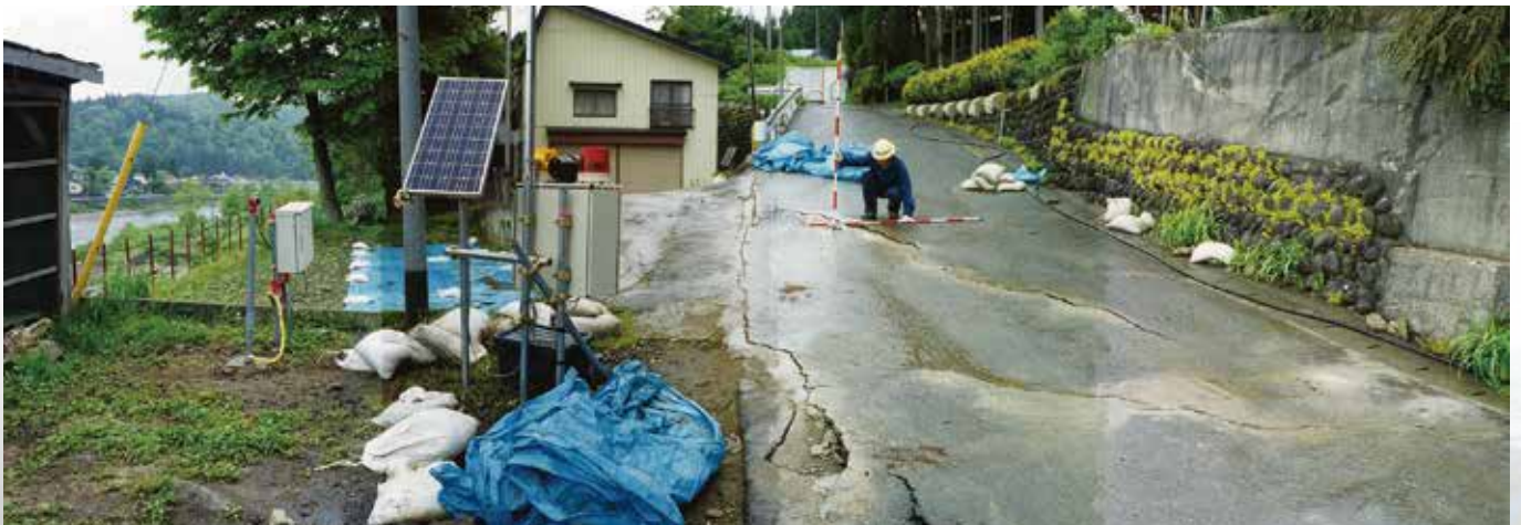
北秋田市森吉下前田の被災状況
