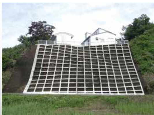
大仙市協和境・野田地区の急傾斜地崩壊対策事業
