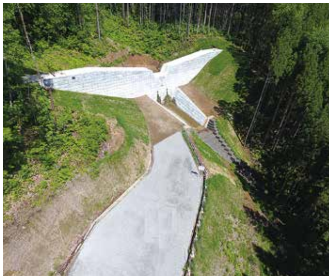
火山砂防・仙北市谷地村沢砂防えん堤2
