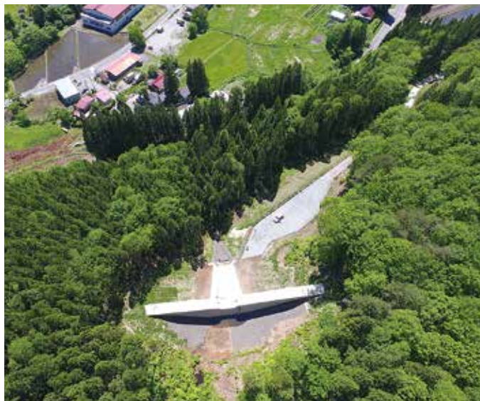
火山砂防・仙北市谷地村沢砂防えん堤1
