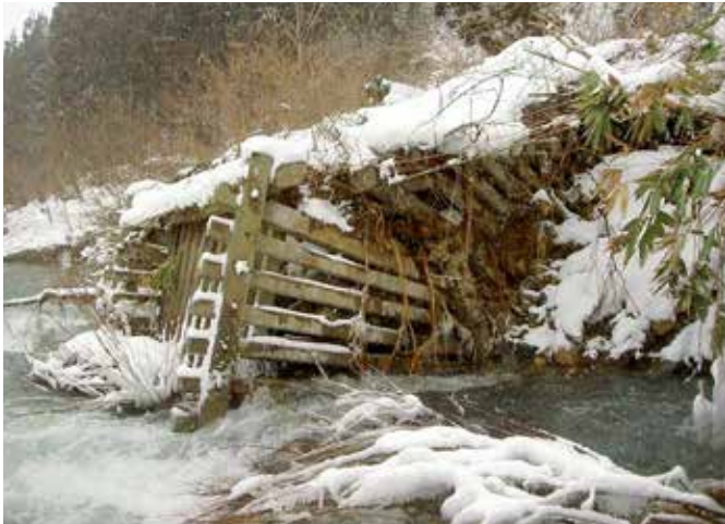
上小阿仁村五反沢地区地すべりの被災状況 3
