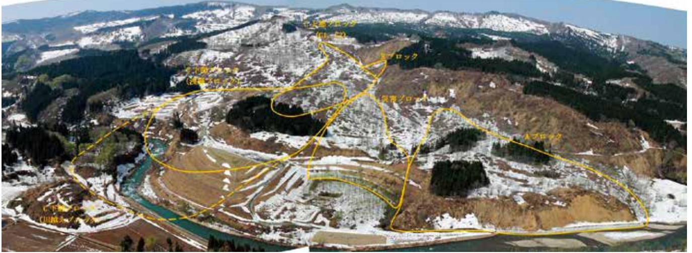
東成瀬村谷地地区の地すべり対策事業（全景）
