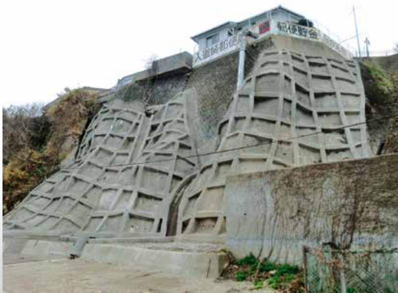
男鹿市・入道崎の急傾斜地崩壊対策事業
