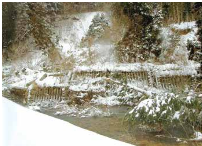
上小阿仁村五反沢地区地すべりの被災状況 1
