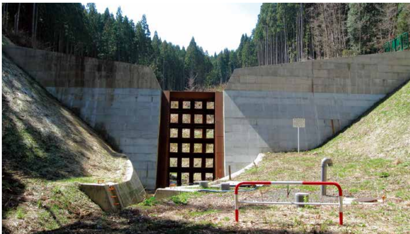
火山砂防・由利本荘市寺田大沢2号えん堤
