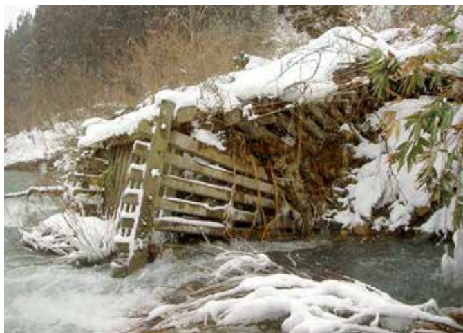
上小阿仁村五反沢地区地すべりの被災状況 3
