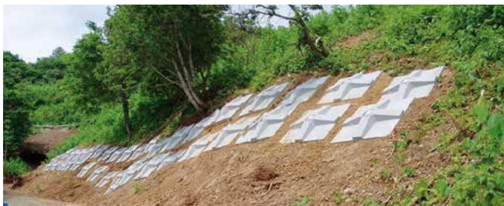
東成瀬村谷地地区の地すべり対策事業 （アンカー工）
