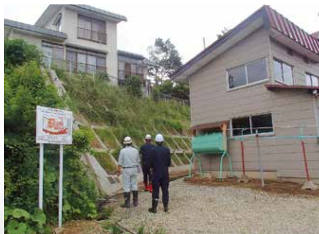
急傾斜地崩壊危険区域 H29.3.31現在
