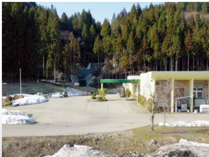
北秋田市森幸苑沢砂防えん堤（要配慮者利用施設含む）
