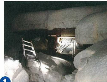
1 平成18年1月5日発生 新潟県十日町市浅原地区
