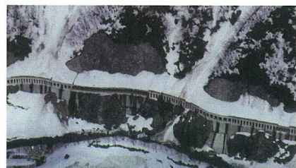
スノーシェッド 冬期間の交通安全を確保するスノーシェッド (新潟県糸魚川市 国道148号) Snow-sheds Snow-sheds ensure traffic safety during winter (Itoigawa City, Niigata Pref., Route 148)
