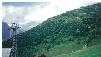
減勢工 大規模な雪崩が予想される所に設置し、雪崩の勢いを弱めます。(新潟県糸魚川市) Energy Dissipator works Avalanche-retarding structures dissipate the energy from moving snow. (Itoigawa City, Niigata Pref.)
