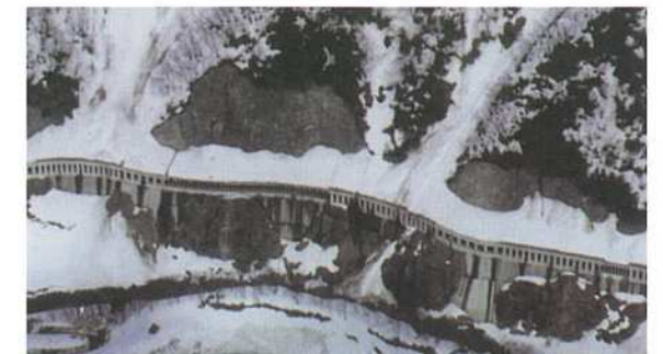
スノーシェッド 冬期間の交通安全を確保するスノーシェッド(新潟県糸魚川市 国道148号) Snow-sheds Snow-sheds ensure traffic safety during winter (Itoigawa City, Niigata Pref., Route 148)
