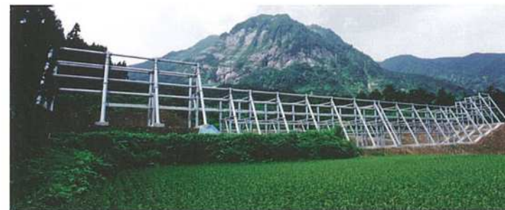
減勢工 大規模な雪崩が予想される所に設置し、雪崩の勢いを弱めます。(新潟県糸魚川市) Energy Dissipator works Avalanche-retarding structures dissipate the energy from moving snow. (Itoigawa City, Niigata Pref.)
