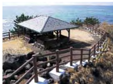
○にかほ市・三崎公園（柵：再生有機建材）
