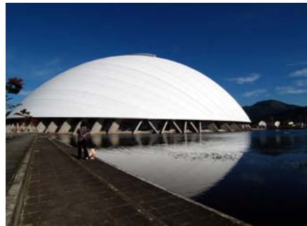
大館樹海ドーム
