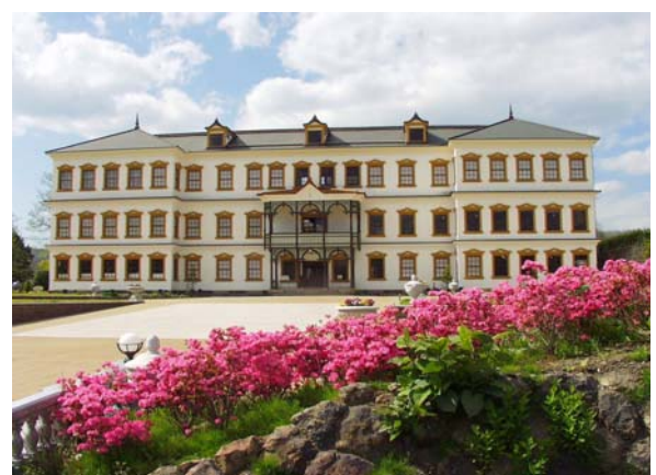
小坂鉱山事務所
