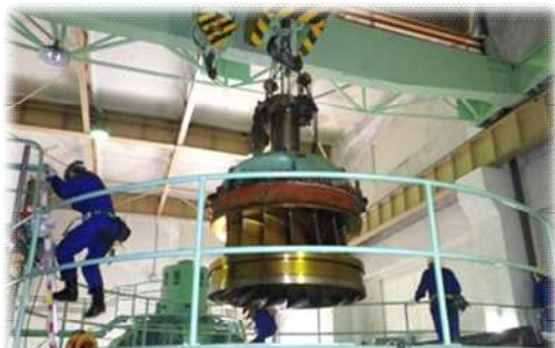
水車ランナの吊り出し(鎧畑発電所1号機)
