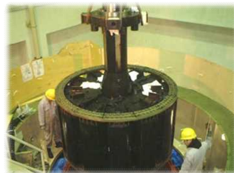
発電機(回転子)の吊り出し (素波里発電所)
