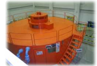
発電機(玉川発電所)
