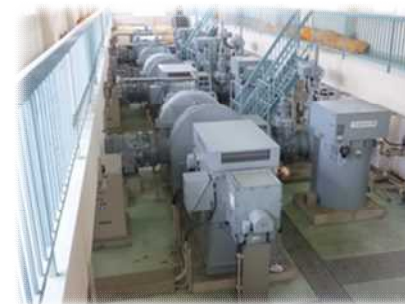
工業用水道の送水ポンプ設備
