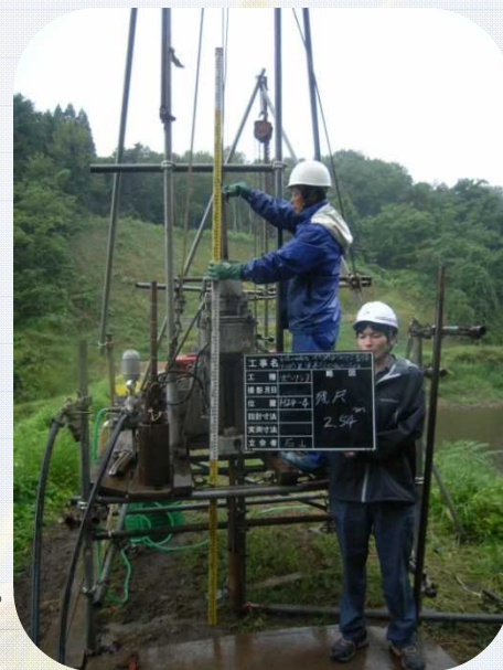
ボーリング調査
