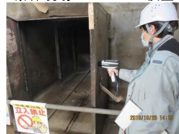
解体現場でのアスベスト検査
