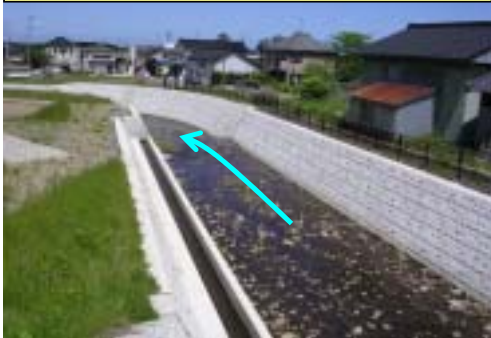
保全家と溪流保全工 蛇行した流向を整え 溪岸の侵食を抑えらるとともに、土石流を安全に流下させる。
