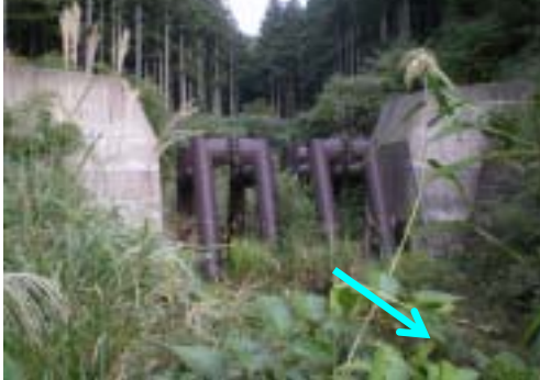
保全家と溪流保全工 蛇行した流向を整え 溪岸の侵食を抑えらるとともに、土石流を安全に流下させる。
