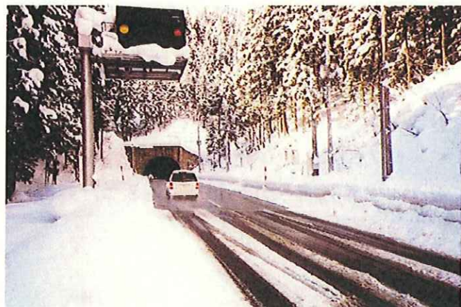
ロードヒーティング(国道285号 大館市)
