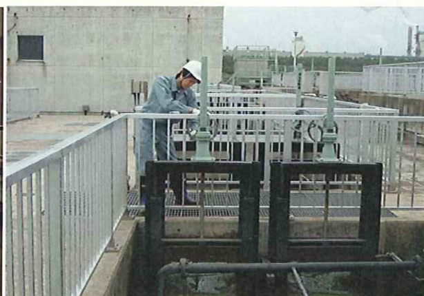
処理施設の点検
