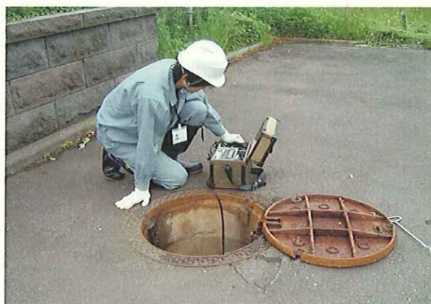
マンホールの点検
