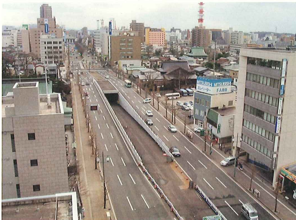
秋田中央道路旭北工区の工事状況
