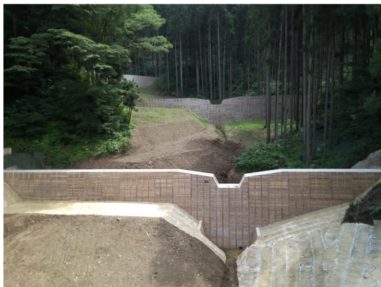
木製残存型枠を使用した治山ダム工
